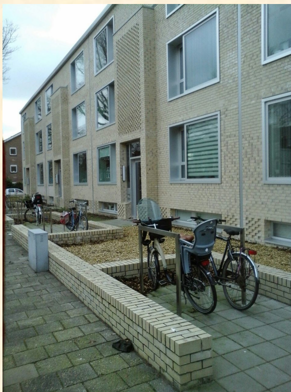
16 huurappartementen in de Jacob van Campenlaan
