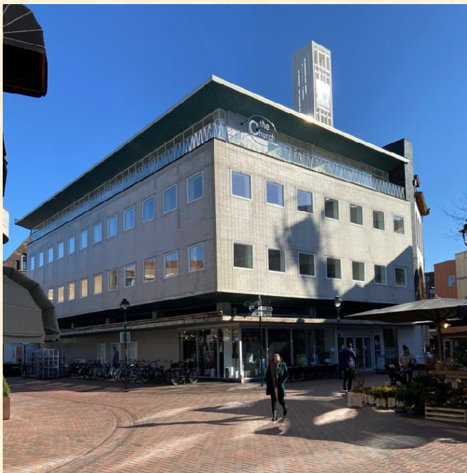
In dit grote pand in de Kerkstraat worden nu op de verdiepingen appartementen gerealiseerd.
