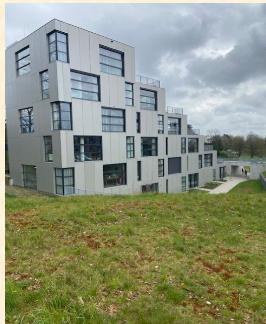
Nieuwbouw in Het Dorp
