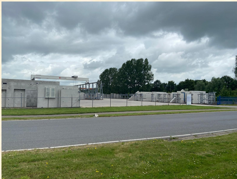
De vervaardigde elementen wachten hier op transport naar de bouwplaats, waar ze worden gemonteerd.
